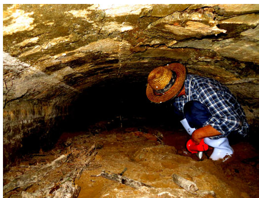
川村飛行場用水隧道陥没により通水不能に
