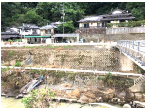
下のガードレールが改修前の道路の高さ5mほど嵩上げされていたのに、1階天井付近まで浸水していた（2020. 7. 25撮影）
