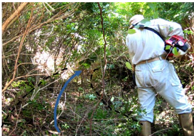
草木に覆われた山の道を、チェーン・ソーや刈払機で拓く（2本の破線の間が道の跡）
