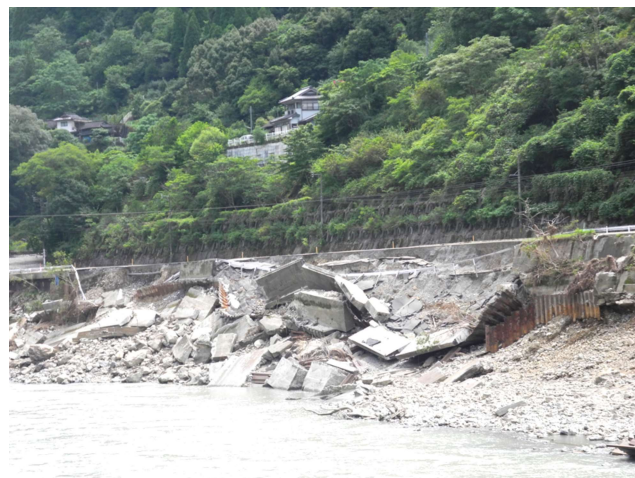
写真2 球磨川右岸国道路盤擁壁の崩落 ～球磨村多武除（たぶのき）付近
